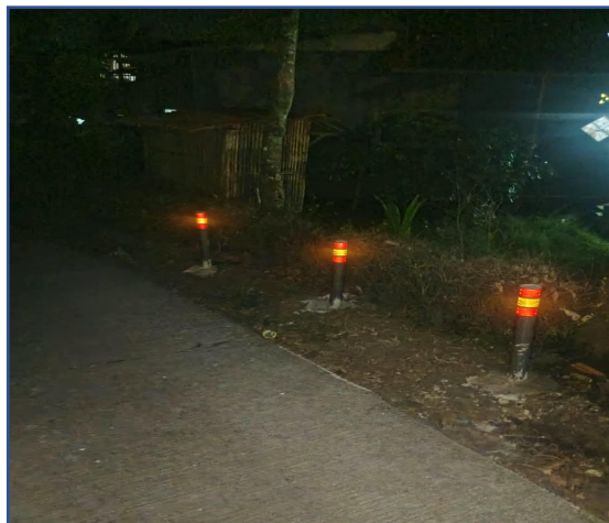
Kondisi jalan setelah pemasangan reflektor pada malam hari
