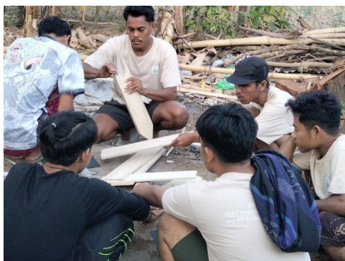
Gambar 4 Pemotongan kayu sesuai desain
