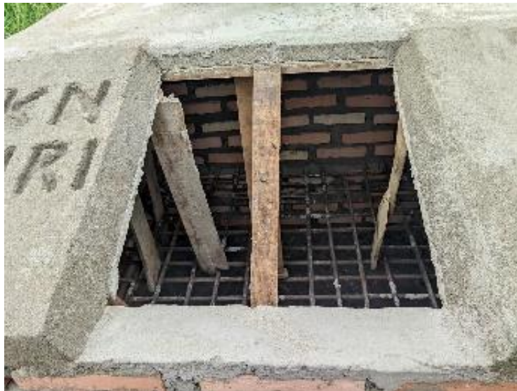
Gambar 5 Lubang Pemasukan Sampah
