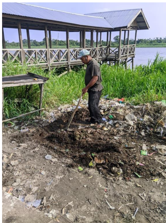
Gambar 1. Lokasi Pembangunan Tempat Pembakaran Sampah
