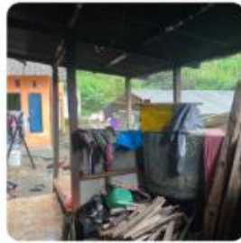
Kondisi bagian belakang rumah
