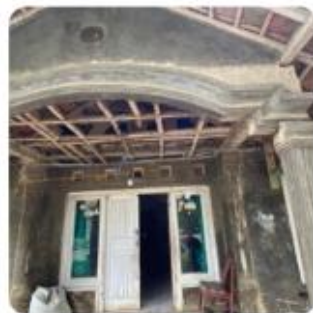
Kondisi bagian depan rumah
