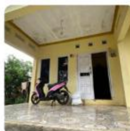
Kondisi bagian depan rumah
