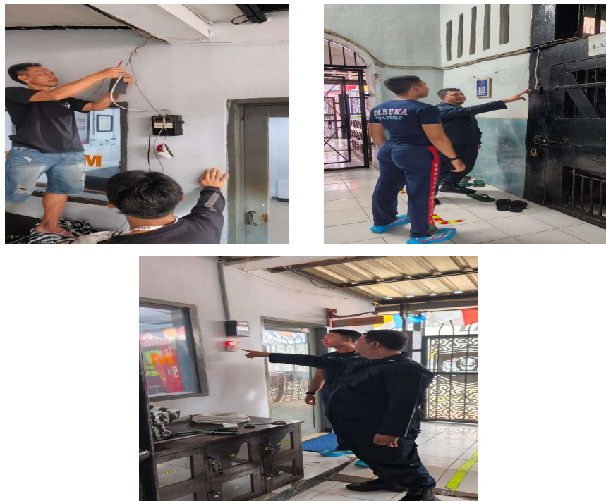
Gambar 2. Proses Pemasangan Panic Button di Dinding Kamar Isolasi
